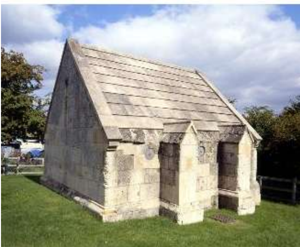
Conduit House on Harcourt Hill
