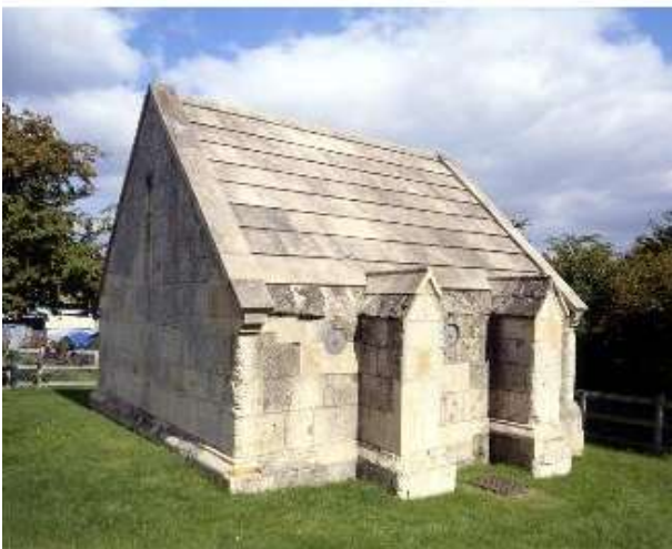
Conduit House on Harcourt Hill
